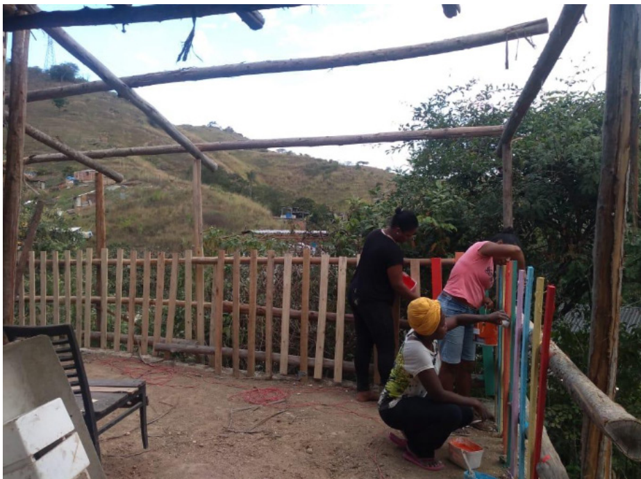
Improvements and small repairs to the local NGO at Serra da Misericórdia (Complexo da Penha, Rio de Janeiro)
