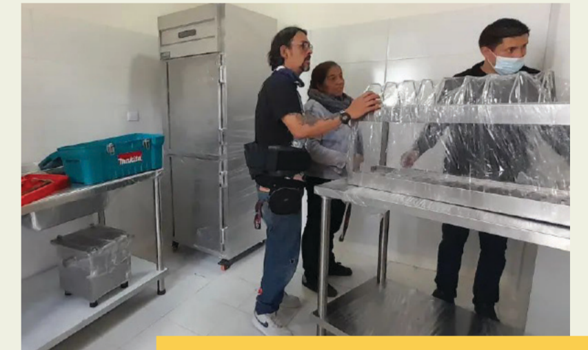
La instalación de electrodomésticos en la cocina comunitaria.
